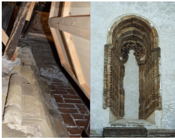
5.- Ventana frontal del presbiterio. Interior y exterior
